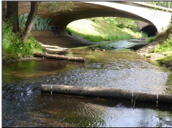
Abb. 8: Prießnitz - Eingebaute Querriegel aus Holz zur Sohlsicherung und Strömungslenkung, 08.06.2017
